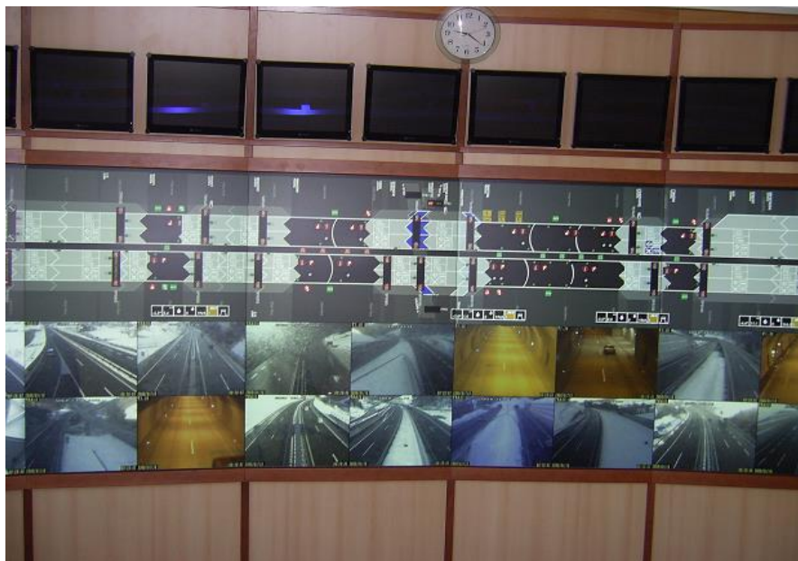
Slika 7: Stenski prikazovalnik Barco (spodaj), SCADA (sredina) in analogni monitorji (zgoraj) v NC Vransko (danes)
