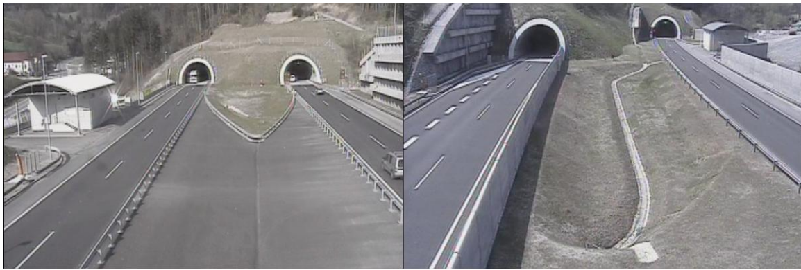
Slika 10: Slike iz vrtljivih kamer; levo zahodni portal, desno vzhodni portal predora Trojane
